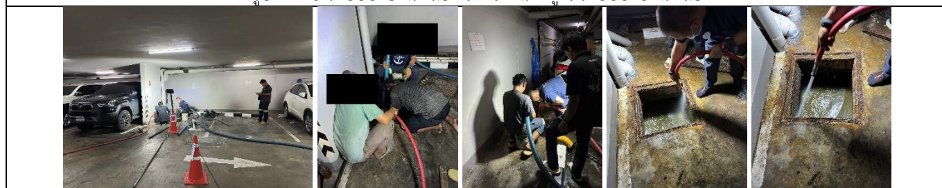
รูปที่ ๗.9 การสูบน้ำส่วนเกินจากระบบบำบัดน้ำเสีย (พ.ค.68)
